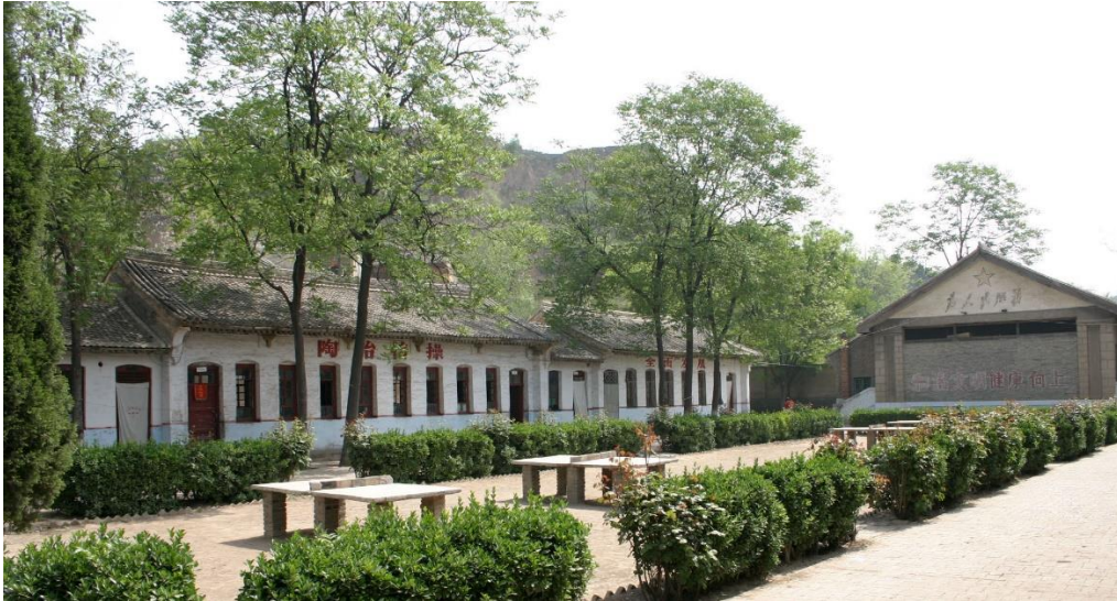
La cour de récréation et les tables de ping-pong (en briques et plaques de béton)
